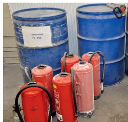
**11.30 Uhr:** In der Löscherwerkstatt kann man einem geöffneten Feuerlöscher mal in den Hals schauen. Turnusmäßig wird das Löschmittel in den rund 2.000 Feuerlöschern im Werk alle zwei Jahre geprüft und ggf. getauscht, damit die Geräte in allen Betrieben und Abteilungen des Werks für den Notfall bereitstehen.
